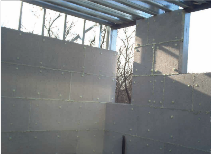
Polisztirol beton öntése 3 nap
