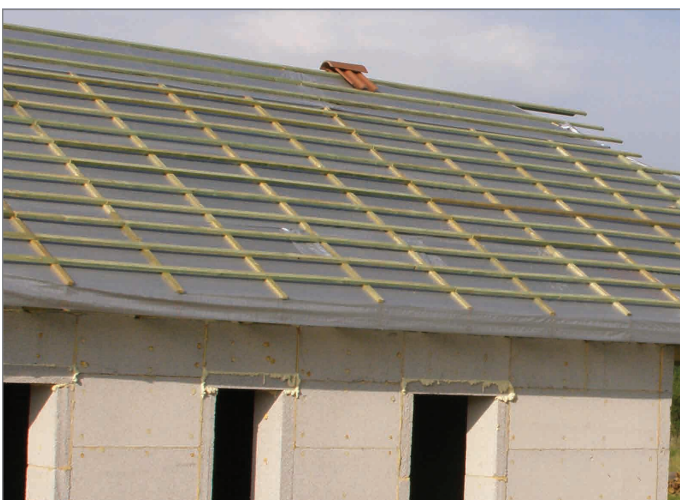
Tetőszerkezet lécezés, fóliázása 2 nap
